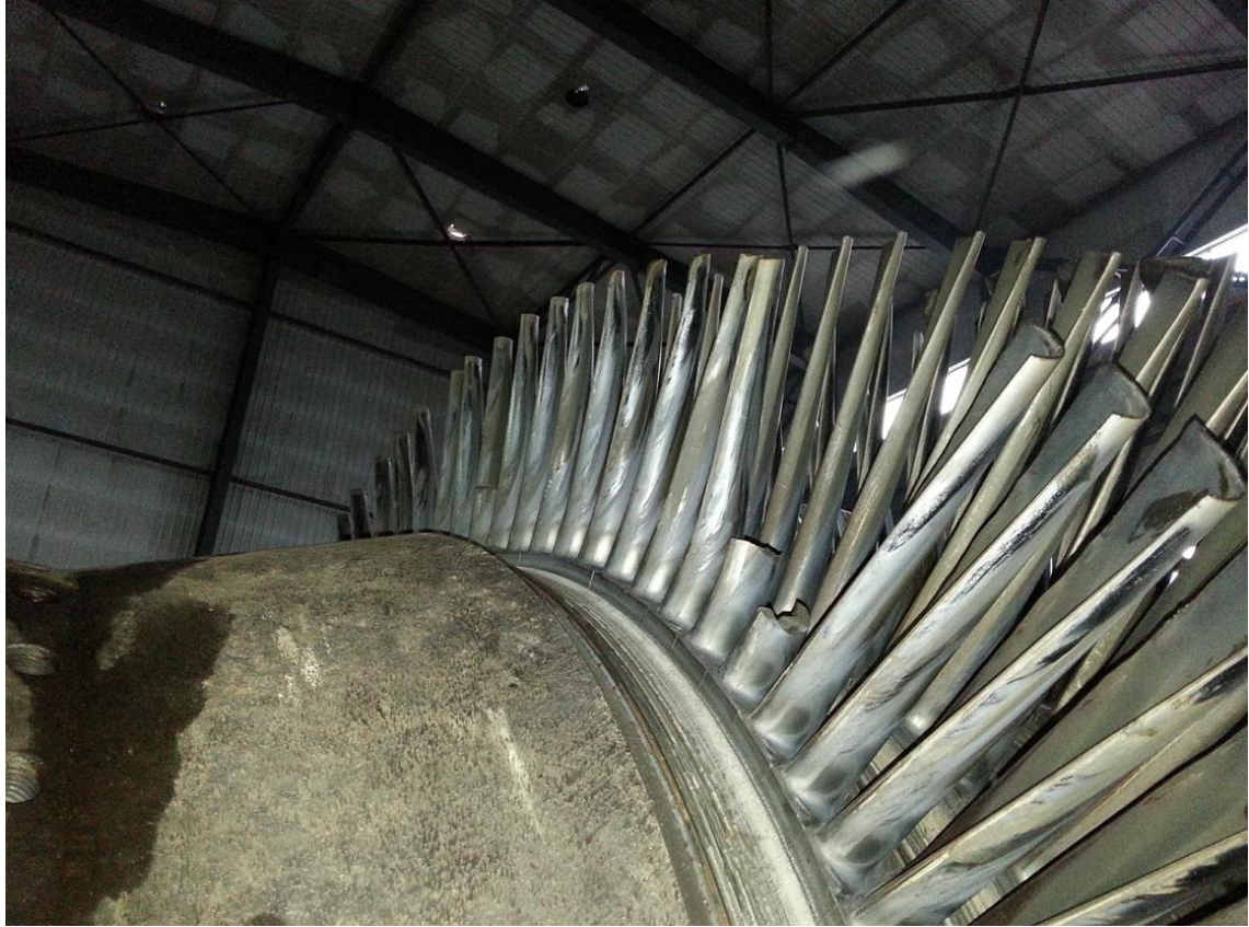
图9 末4级叶片断裂的现场照片
