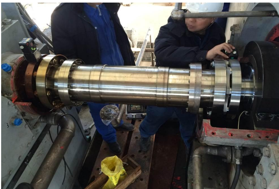
图 11 现场更换联轴器
